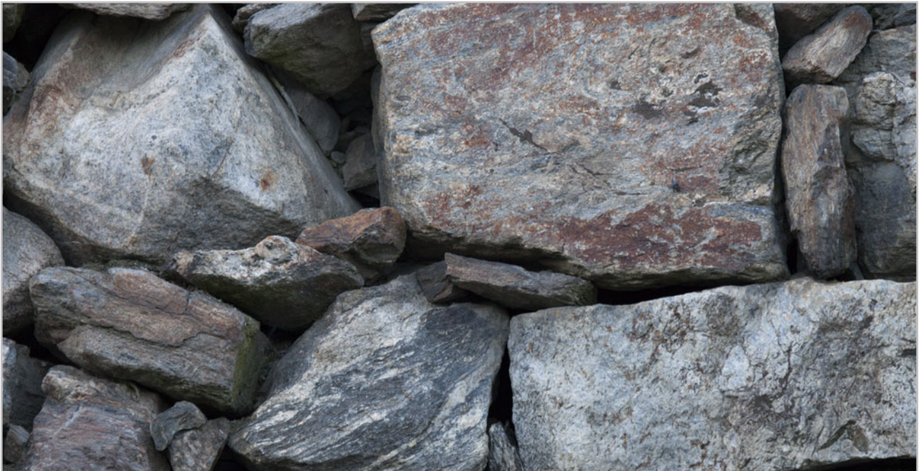
L'immagine mostra quanta fatica e perizia fossero necessarie per la realizzazione dei muri a secco di sostegno (foto: M. Brigatti)
